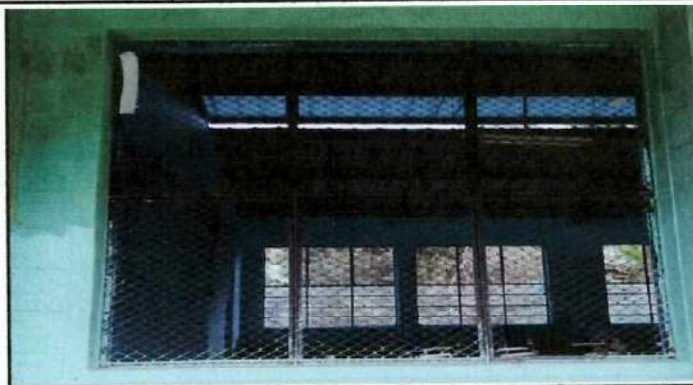
Foto 2: CAMBIO DE VENTANAS POR VENTAS CON BALCON
