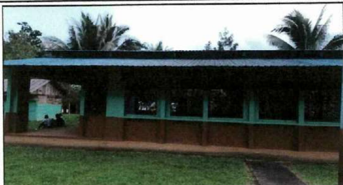
Foto1: SUSTITUCION DE LAMINA DETERIORADA POR LAMINA TROQUELADA
